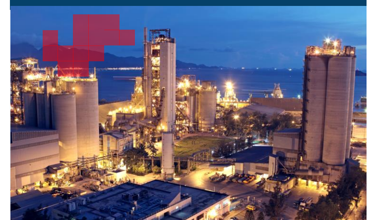
Überwachung von Industrieanlagen
